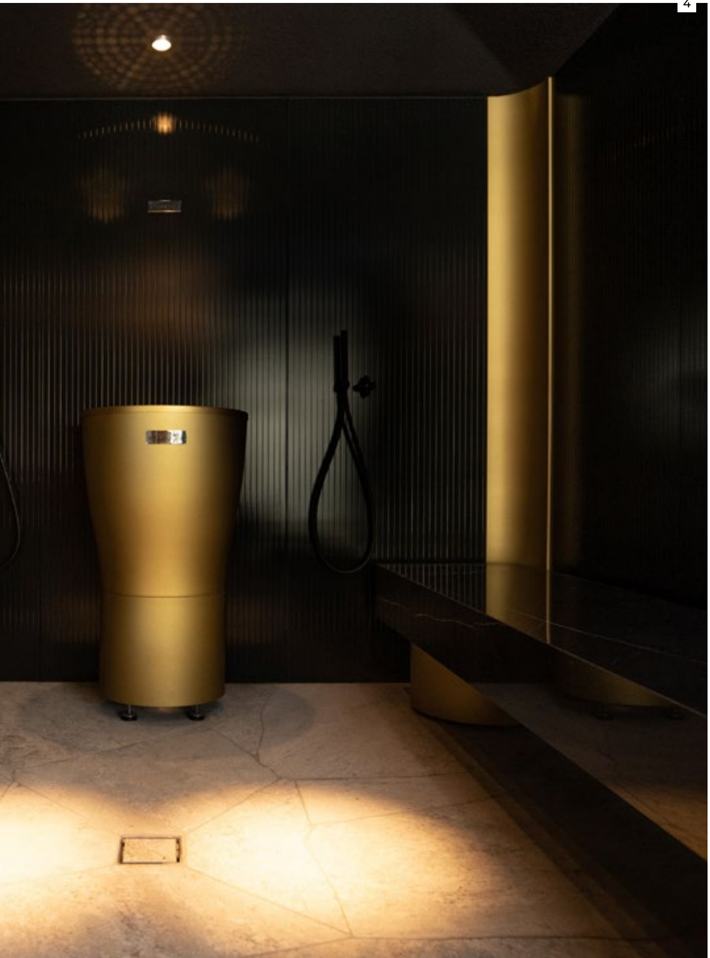
4- Glamour Steam Room mit Rillenglaswänden und Ecostone-Sitzbank.
