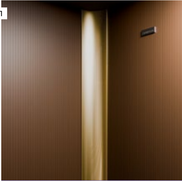
1- Eckfeiler und Wand aus anodisiertem Aluminium.
