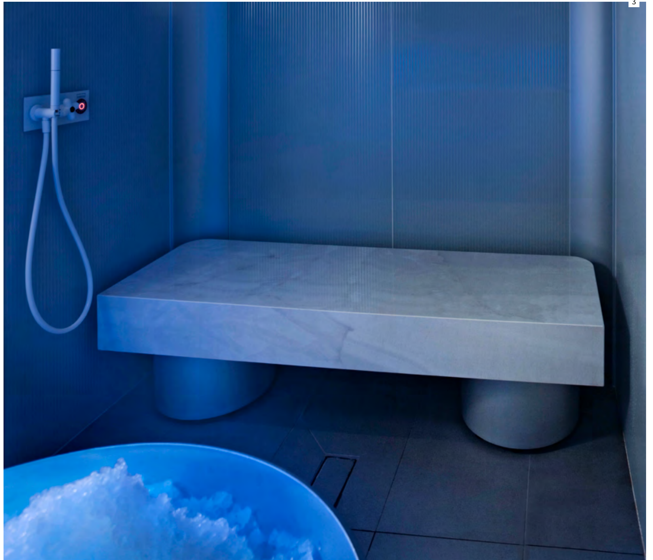
3- La panca sospesa e staccata dalla parete favorisce le operazioni di pulizia.
